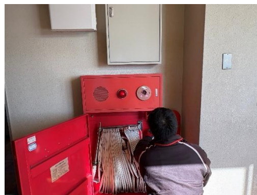
【消火栓の確認】
