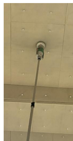
【点検作業の確認】
