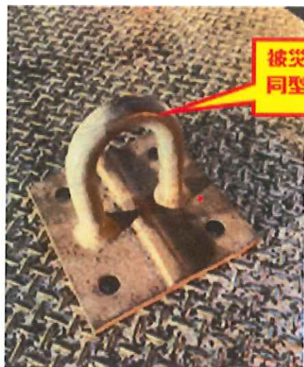
床面に、後付引入金物が 固定されていた場所
