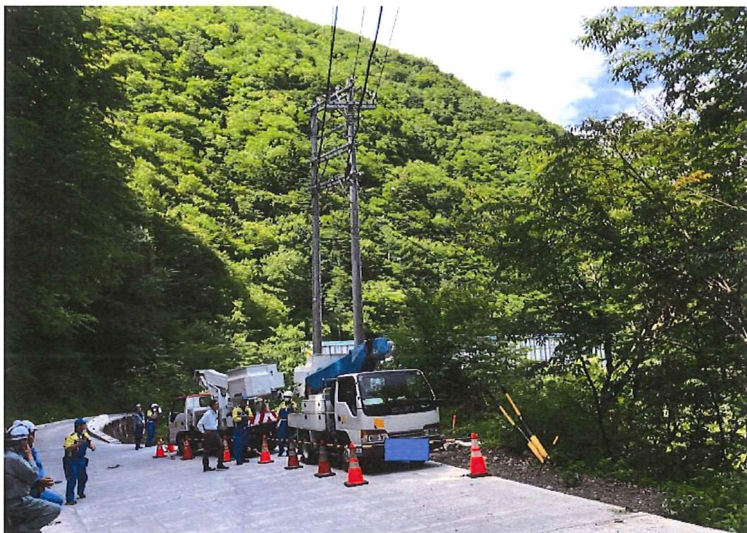
配電部門においても、過去「サイドブレーキ忘れ」や「輪止めの設置不足」、「傾斜地での設置方向誤り（後下がり）」、「ジャッキ操作順誤り」などにより同種の重篤災害が発生しています（過去の類似災害の措置報告書を添付しておりますのでご参照ください）。
